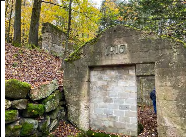
Possible accès principal de la centrale avec la pierre millésimée 1915 de la centrale, 2023 Source : L'Usine à histoire(s), 2023
