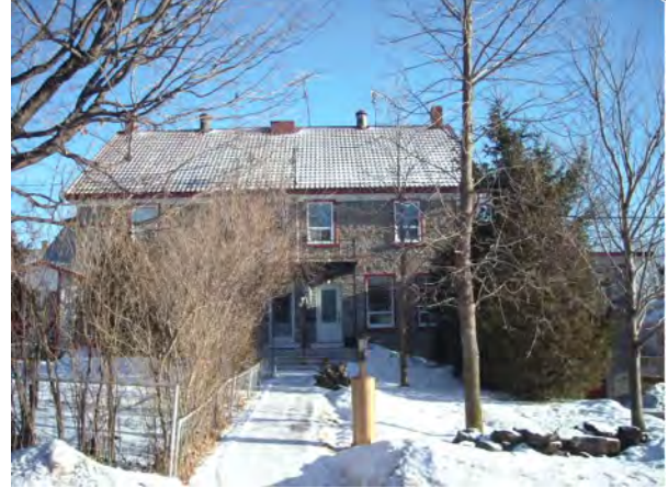
Ancien Collège Saint-Jean-Chrysostome des Frères des Écoles Chrétiennes entre 1930 et 1952. Première école modèle construite en 1873, possiblement tenue par des laïcs, 1950 selon le rôle d'évaluation foncière. 86-88, rue Saint-Clément, Saint-Chrysostome Source : MRC du Haut-Saint-Laurent
