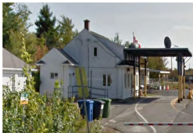
Poste de douane de Covey Hill, date inconnue. 2, route 203, Havelock Source : Google Street View, 2023
