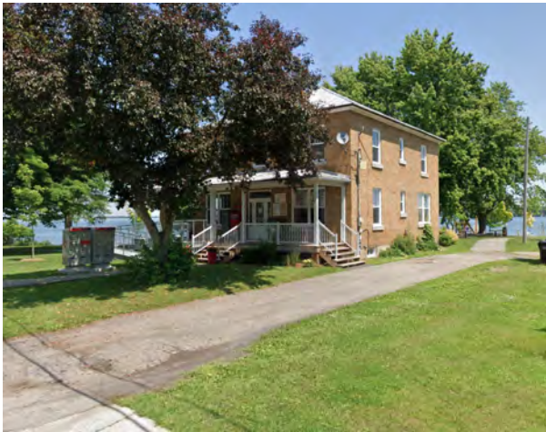
Ancien presbytère de la paroisse Saint-Anicet (bureau paroissial, centre communautaire et bureau de poste), 1936 225, rue de la Fabrique, Saint-Anicet Source : Google Streetview, 2022
