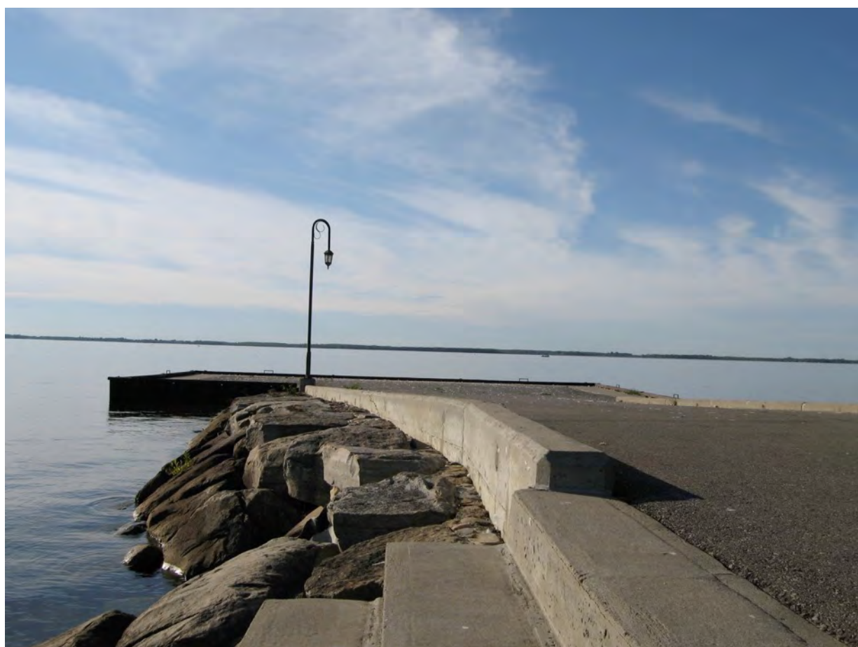
Quai public de Saint-Anicet, construit en 1862, refait en béton en 1927. Saint-Anicet.
