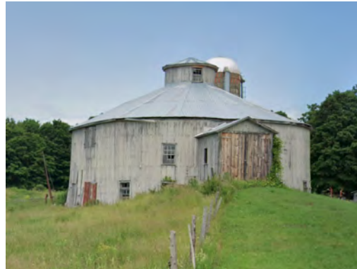
Grange ronde, date inconnue 883, chemin Ridge, Hinchinbrooke Source : Google Streetview, 2022
