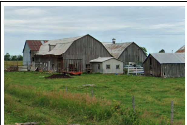
Ensemble de granges-étables à toit à dos d'âne, avant 1940 1448, 5e Rang, Très-Saint-Sacrement Source : Google Streetview, 2021
