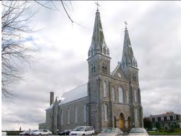
Église Saint-Jean-Chrysostome, 1860-1861. Saint-Chrysostome Source : CPRQ, 2003. RPCQ, en ligne
