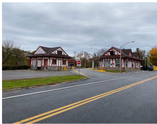
Poste de douane de Rivière-à-la-Truite, 1932. 980, Autoroute 138, Elgin Source : L'Usine à histoire(s), 2023
