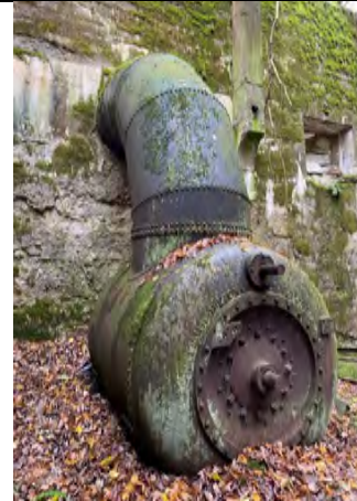
Conduite forcée et turbine William Hamilton de la centrale, 2023 Source : L'Usine à histoire(s), 2023
