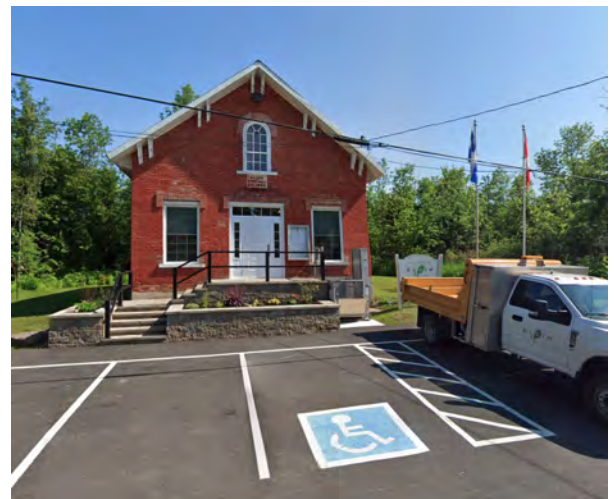
Hôtel de ville d'Elgin, 1869 933, chemin de la 2e Concession, Elgin Source : Google Streetview, 2023
