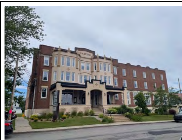
Ancien hôtel Le Château, après 1926 8-10, rue King, Huntingdon Source : L'Usine à histoire(s), 2023
