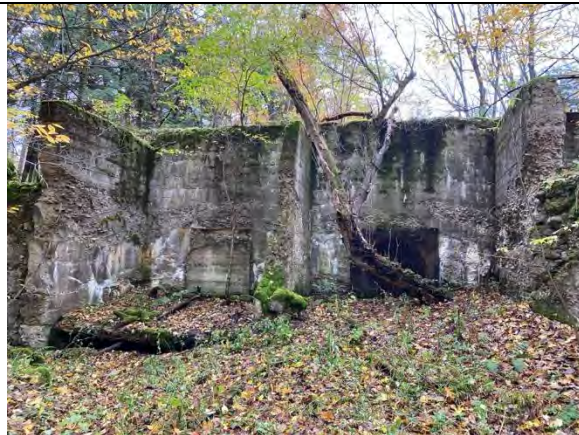
Prise d'eau de la centrale, l'ouverture de droite est grillagée et donne toujours accès à la conduite forcée, 2023 Source : L'Usine à histoire(s), 2023
