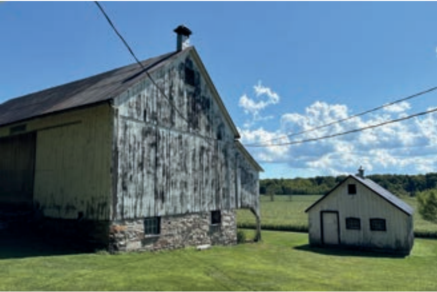
Grange-étable à soubassement en pierre (1898) ; 1926, rang de Tullochgorum, Ormstown
