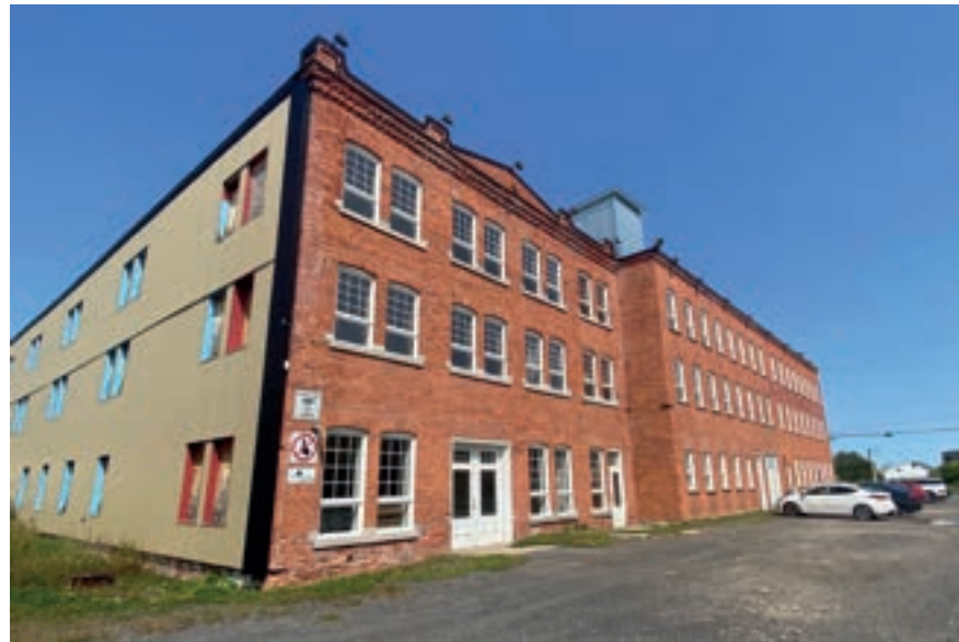
Ancienne usine Borden (1886) ; 72, rue Dalhousie, Huntingdon
