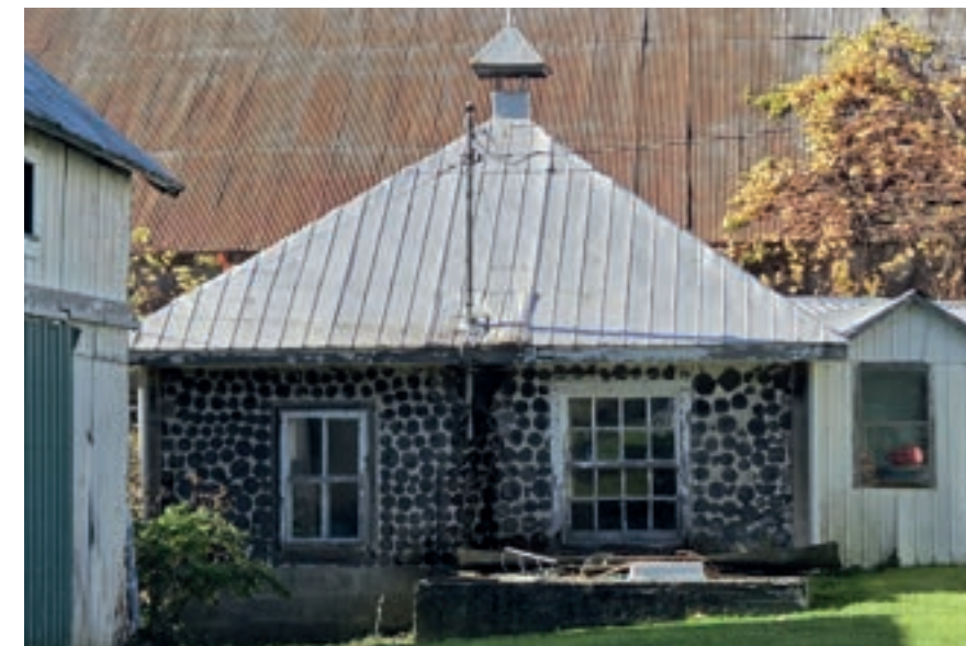
Bâtiment agricole en bois cordé ; 1121, chemin Rankin
