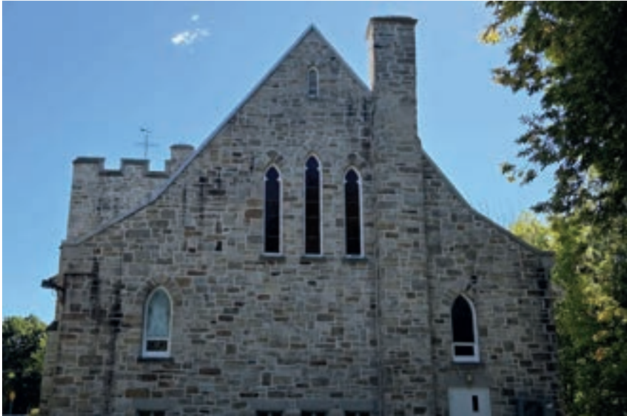
Mur en grès de l'église Howick United ; 2, rue Bridge, Howick
