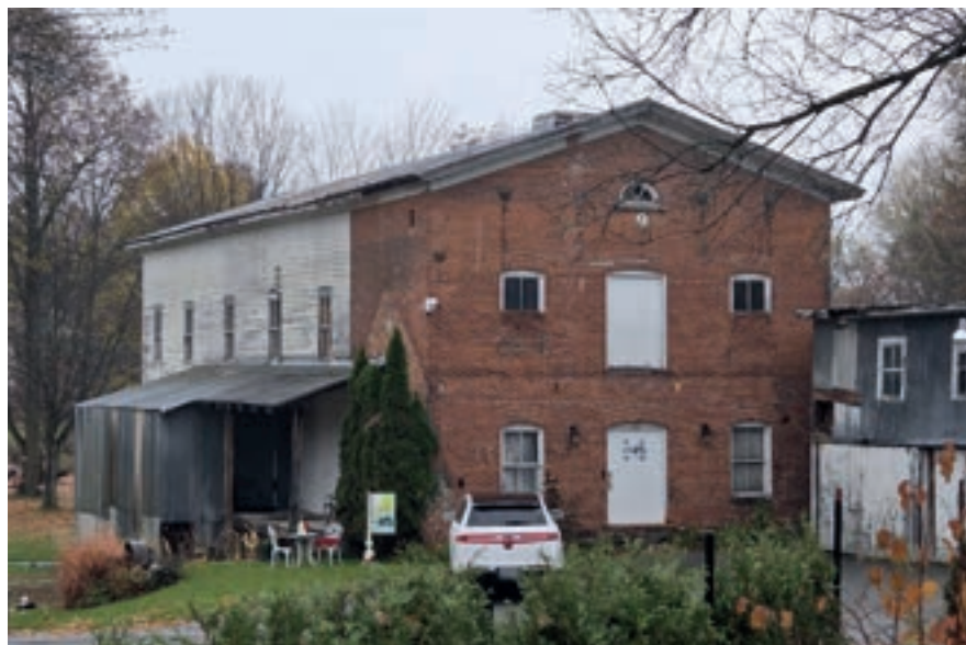
Moulin de Dewittville (1853) ; 182, chemin Fairview
