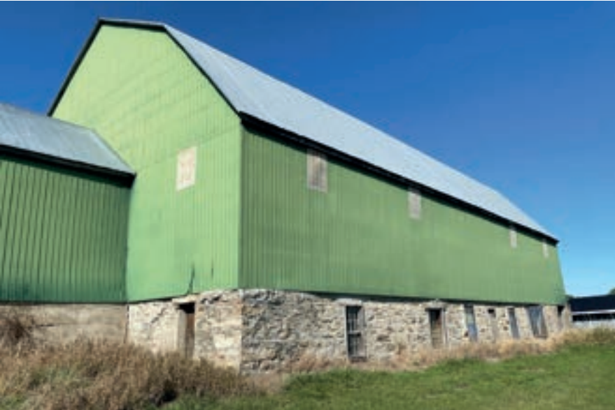
Grange à soubassement en pierre ; 2271, chemin de la Rivière-des-Anglais, Très-Saint-Sacrement
