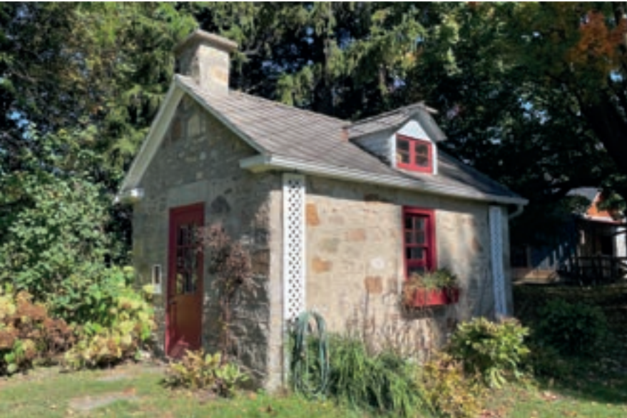
Ancienne laiterie ; 15, route 138-A, Godmanchester
