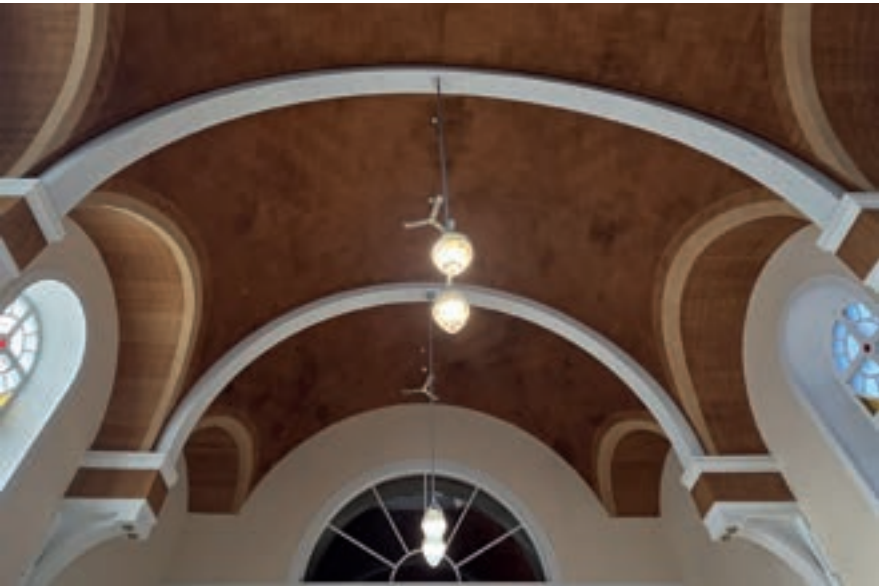
Voûte conservée de l'église de Saint-Anicet ; 1560, rue Saint-Anicet, Saint-Anicet
