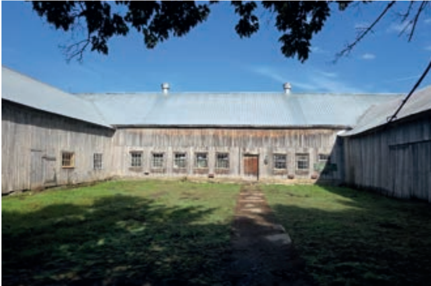
Grange en U ; 2559, rue de la Rivière-Châteauguay, Ormstown
