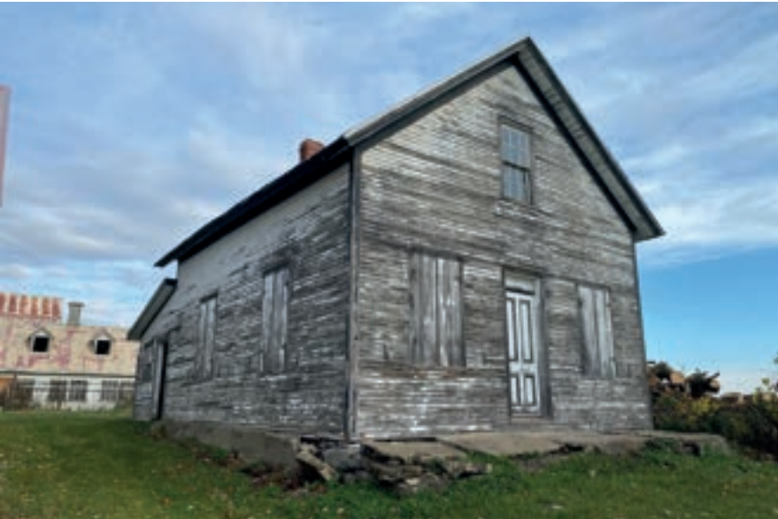
Ancienne école de rang Quesnel ; 0000, chemin de la Concession-Quesnel, lot 3900-88-7054, Saint-Anicet
