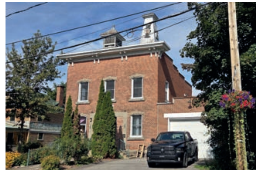
Ancien hôtel de ville et caserne d'Ormstown (1900-1901) ; 81, rue Lambton
