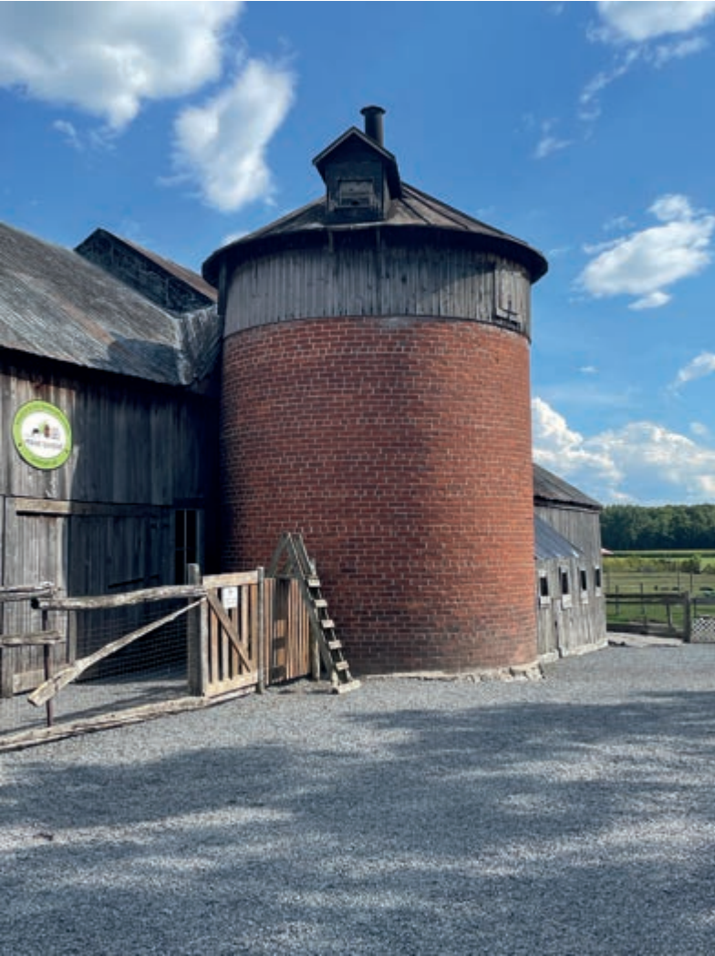
Silo en brique ; 1082, chemin Upper Concession
