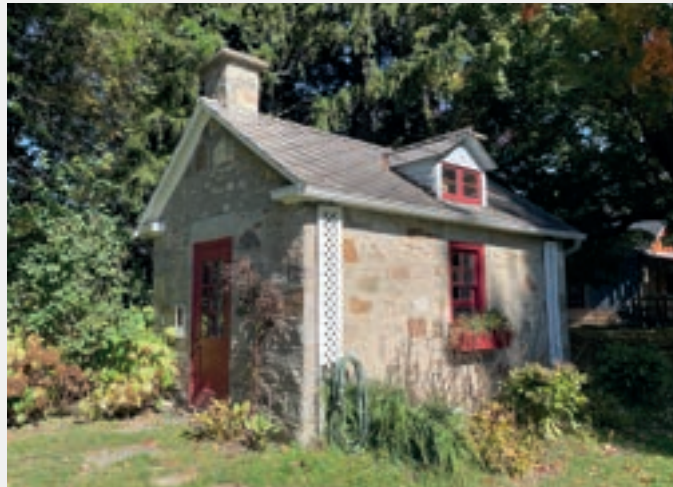
Ancienne laiterie ; 15, route 138-A, Godmanchester
