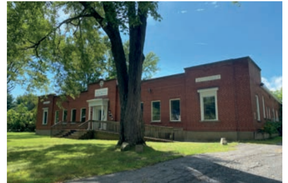
Ancien édifice du Huntingdon Gleaner (1939) ; 220, rue Châteauguay, Huntingdon
