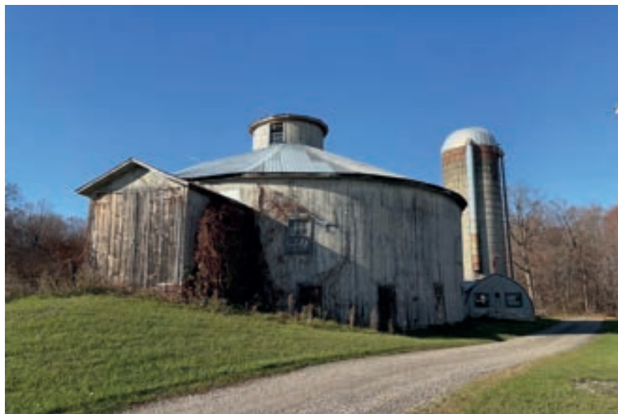
Grange-étable ronde ; 883, chemin Ridge
