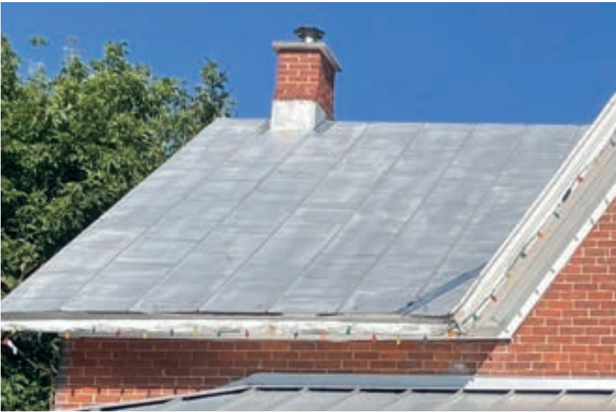
Couverture en tôle pincée ; 2051, chemin Lower Concession, Ormstown
