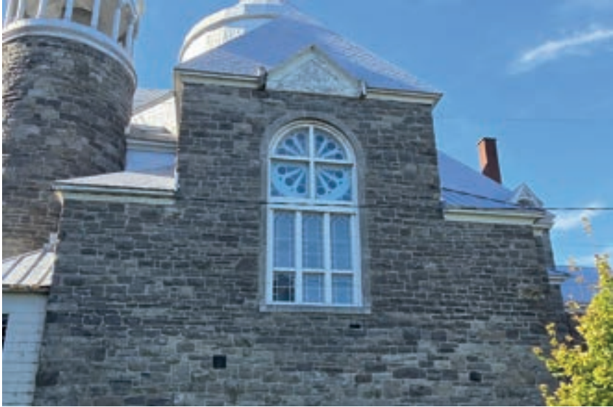
Mur en dolomie de l'église de Saint-Anicet ; 1560, rue Saint-Anicet, Saint-Anicet
