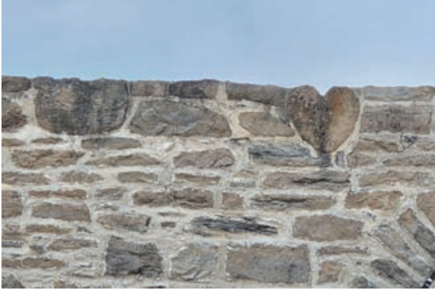
Mur en dolomie des vestiges de l'église Calvin Presbyterian ; 1410, chemin de la Rivière-La Guerre, Saint-Anicet
