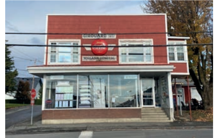
Magasin-général Girouard ; 449, chemin de l'Église
