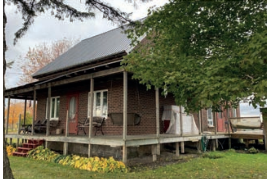
75, chemin de la Baie
