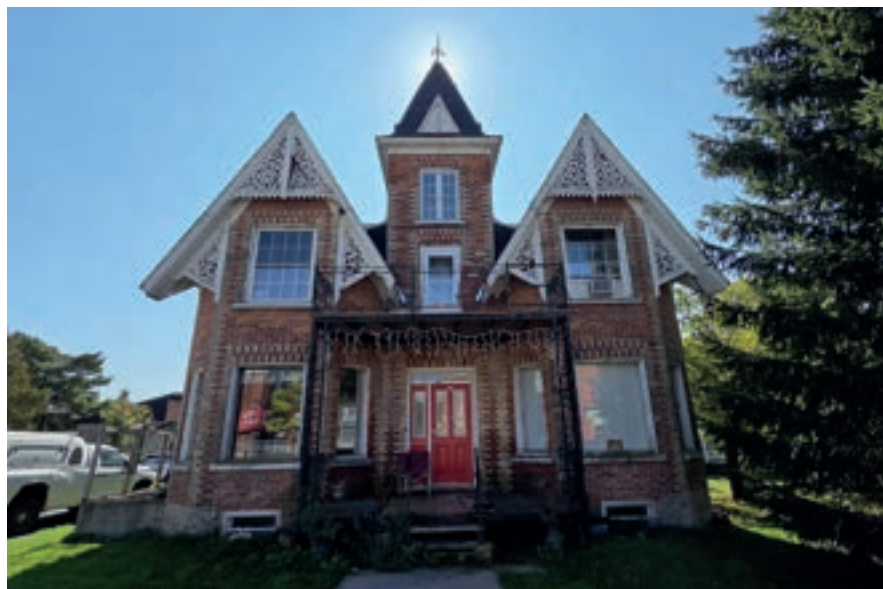
Maison Walsh (1883) ; 50, rue Lambton
