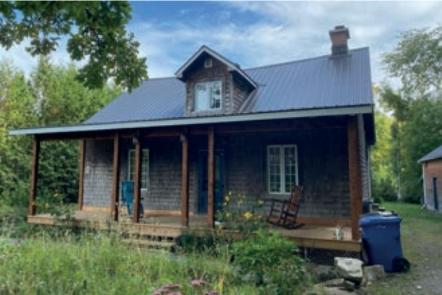
Maison du pasteur James Anderson (1838) ; 16, rue Lambton
