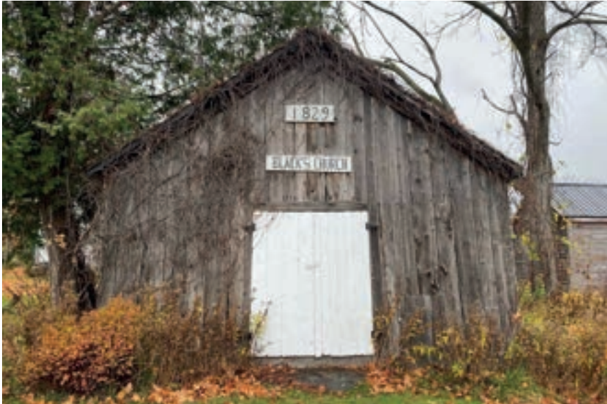
Black’s Church (1829) ; 1743, chemin de la 1 ère Concession
