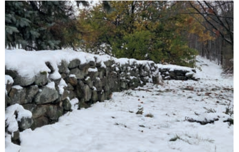
Muret en pierre ; 164, route 202
