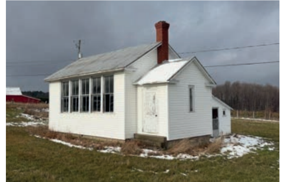
Ancienne école de rang ; 555, chemin Covey Hill
