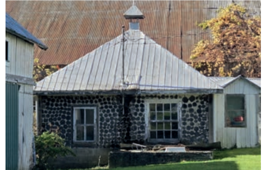
Bâtiment agricole en bois cordé ; 1121, chemin Rankin
