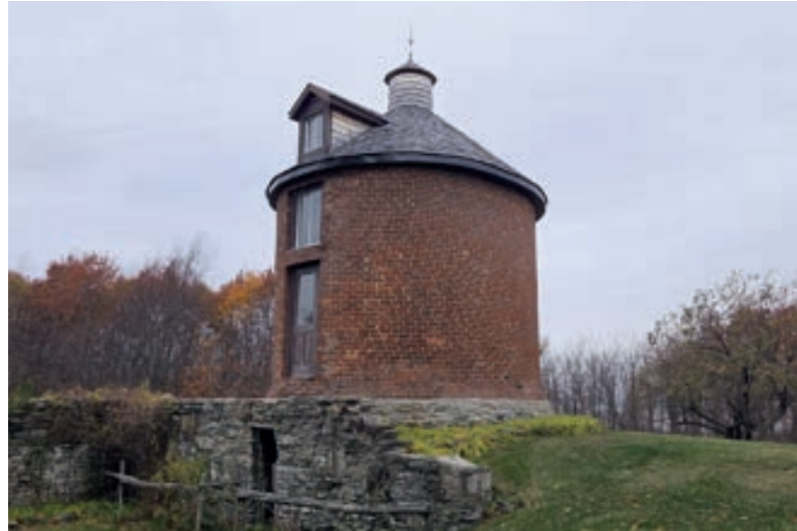
Silo en brique ; 3958, montée Clinton
