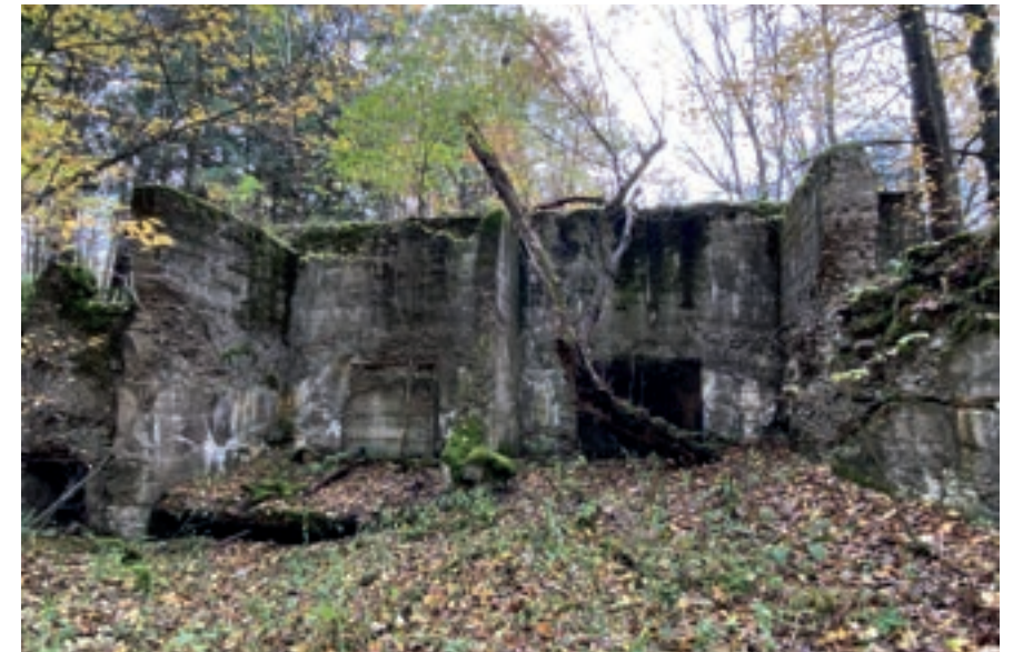
Vestiges de la centrale hydroélectrique de Powerscourt (1914-1915) ; 2562, chemin de la 1 ère Concession
