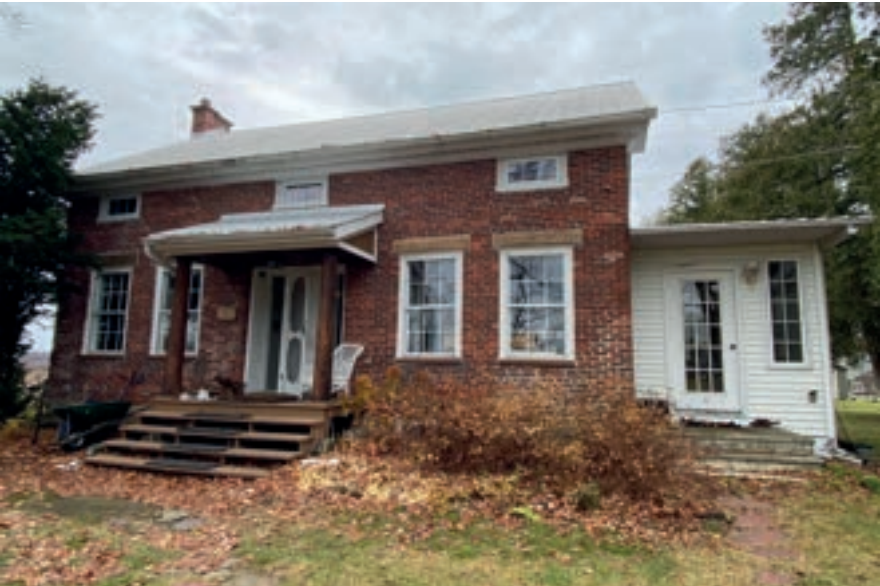
Maison James Fraser (agrandissement de 1850) ; 7712-7798, chemin de la Pointe-Fraser
